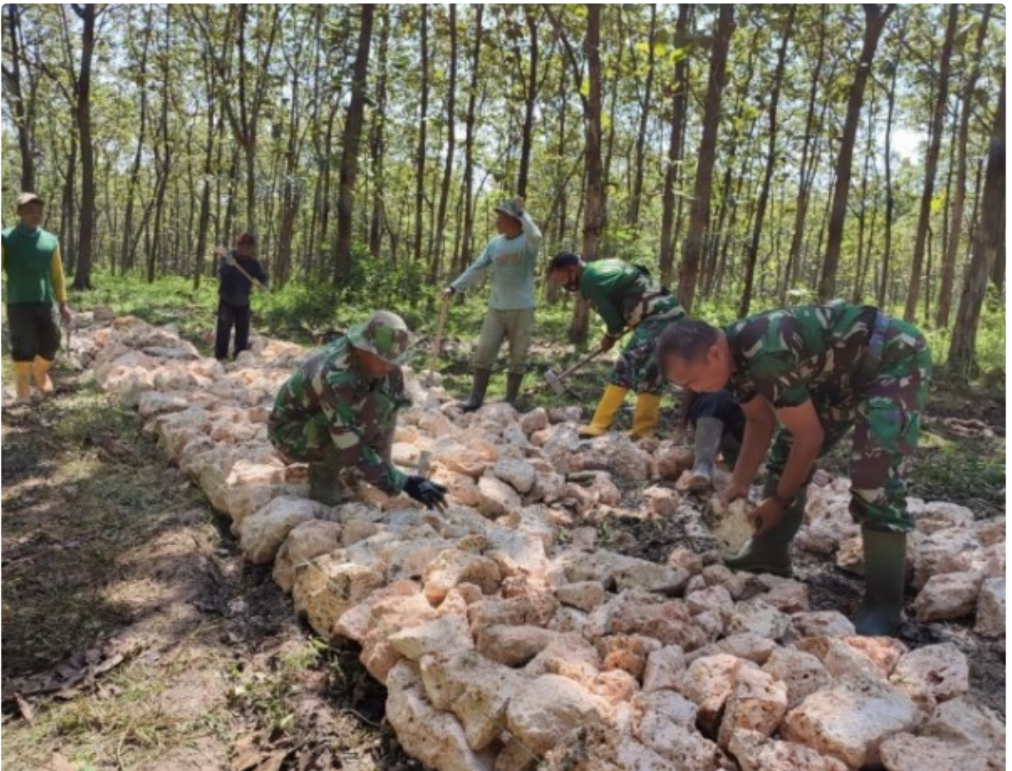
Satgas TMMD ke-113 Kodim 0721 Blora bersama warga Desa Pengkoljagong, Kecamatan Jati, menata material untuk jalan yakni batu sebagai dasar jalan
